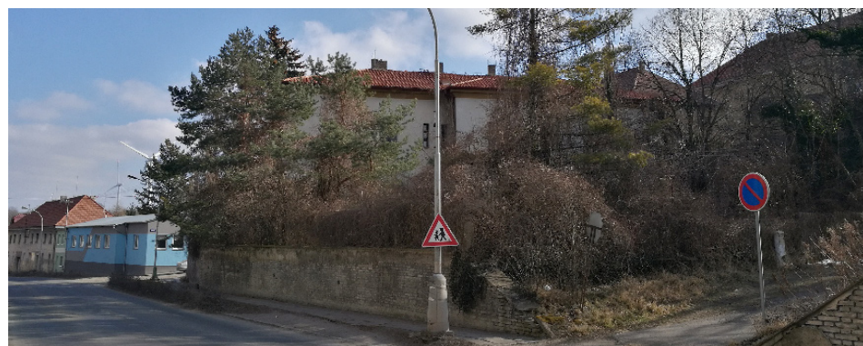
Současná žalostná podoba objektu bývalé fary
